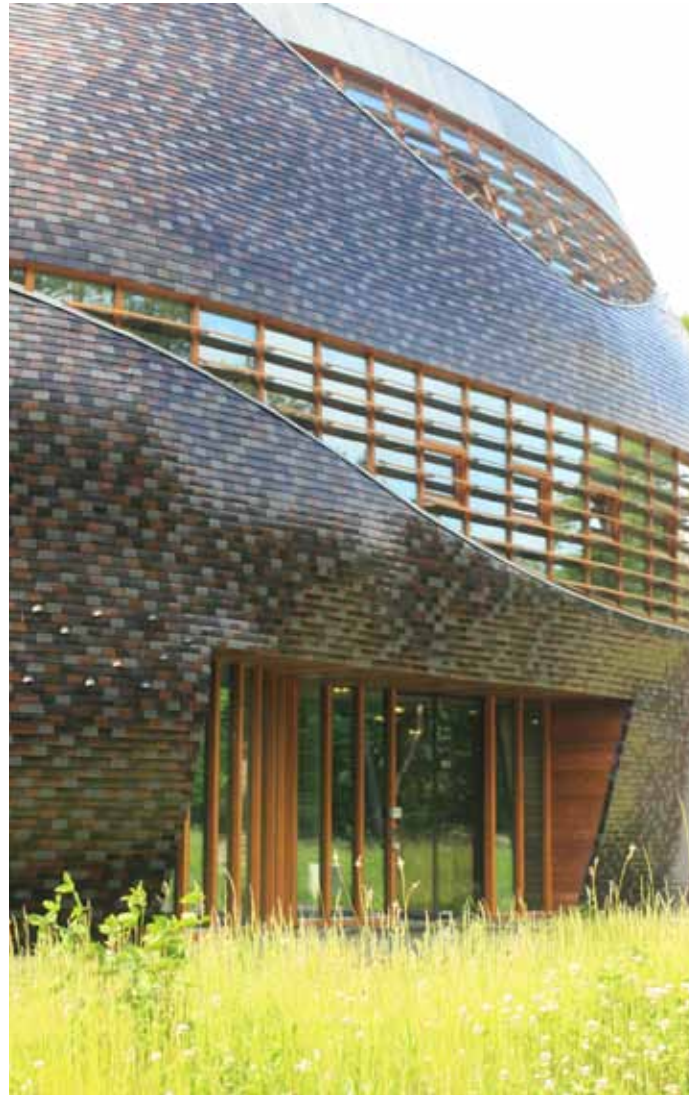
Nieuwe bebouwing op oude buitenplaats Schoonoord
